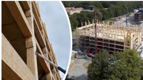
Sex våningar högt blir parkeringshuset i Sege park det största i Sverige som byggs i trä. Foto: Lars Däreberg & Johan Rosholm
